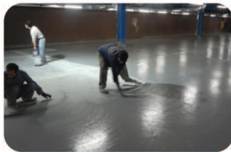
۸- اجرای مرحله دوم اپوکسی (در صورت نیاز)
