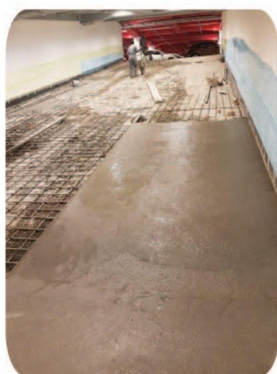
۲- مش بندی و بتن ریزی رمپ
